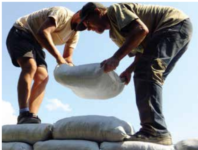
↑ Budovanie múrov Hobiteho domu technikou earthbags
