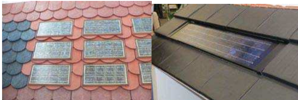
Fotovoltaické panely integrované do krytiny různým způsobem. Foto: EkoWATT
