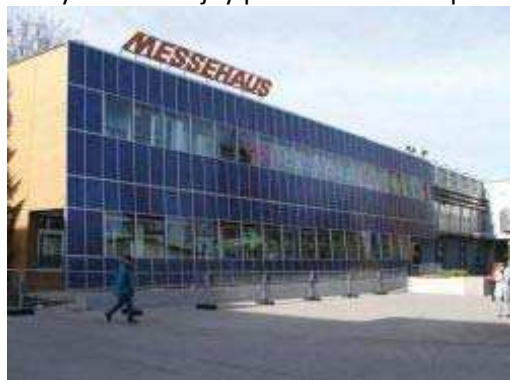
Budova s fotovoltaickou fasádou (Wels, Rakousko). Foto: EkoWATT
