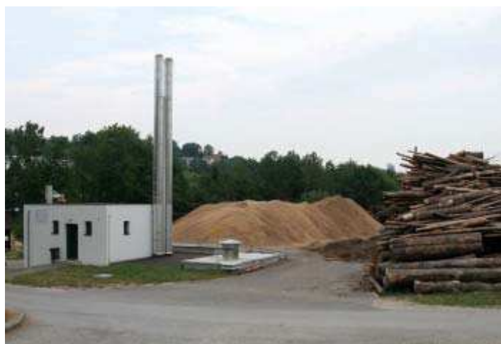
Centrální vytápění na dřevní štěpku (Rakousko). Foto: EkoWATT
