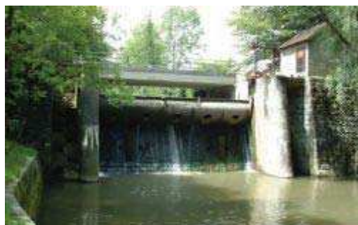
Malá vodní elektrárna (Rakousko). Foto: EkoWATT
