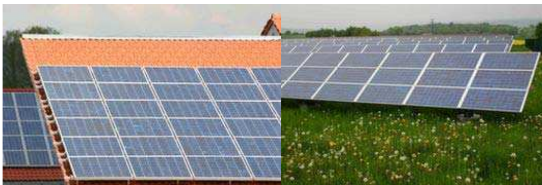
Pevně umístěné panely - roční produkce cca 110 kWh/m 2 (100%). Foto: EkoWATT
