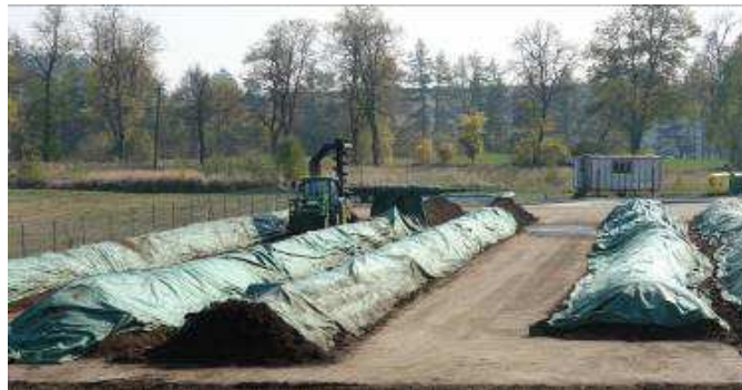
Obr.: Kompostárna využívající technologii kompostování na volné ploše
