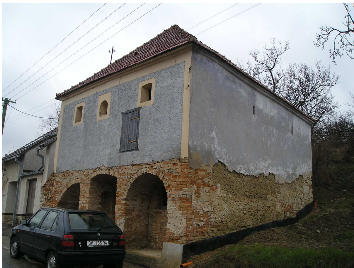
Obr. 5 Hulatův sklep v Nemčičkách
