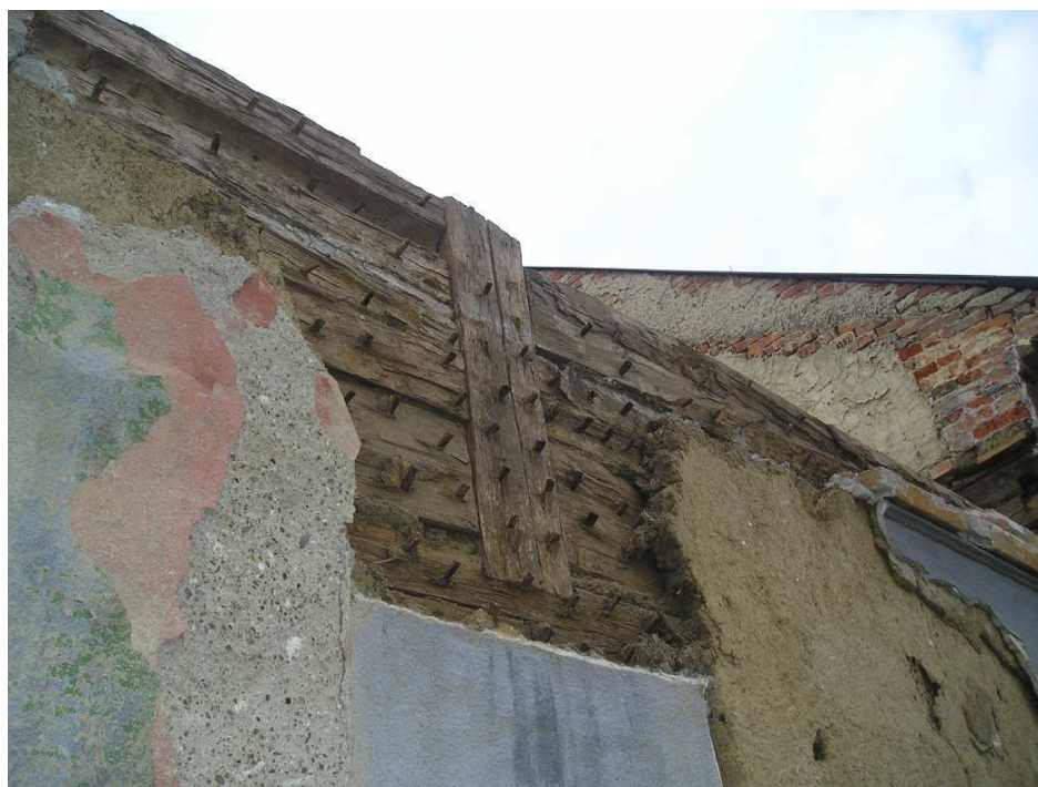
Obr. 1 Roubený dum v Rymicích se silnou omazávkou Při bourání. Tzv. ježkování – systém dřevěných kolíků – sloužil k dobrému spojení dřevěné konstrukce se silnou vrstvou hliněného materiálu.
