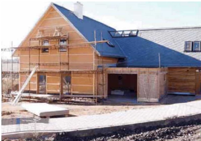
Montáž fasády objektu
