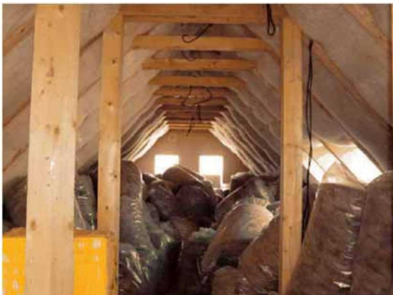
Zateplení krovu rohožemi z ovčí vlny
